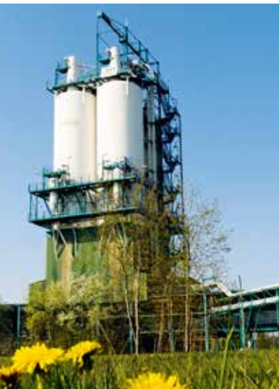
Staubsilos und Rauchgasentschwefelungsanlage (REA)
