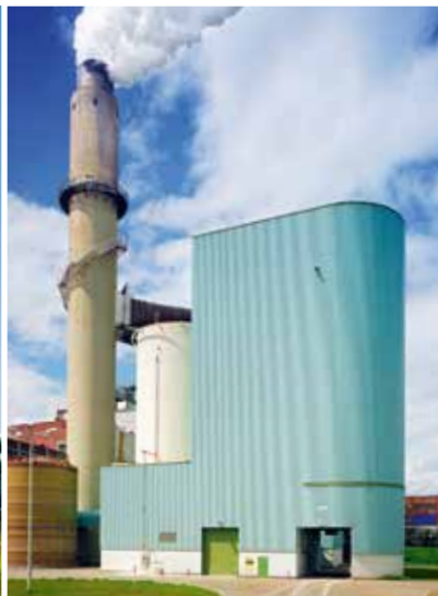
Staubsilos und Rauchgasentschwefelungsanlage (REA)
